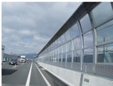
採用業種：土木 採用箇所：NEXCO 西日本遮音壁
